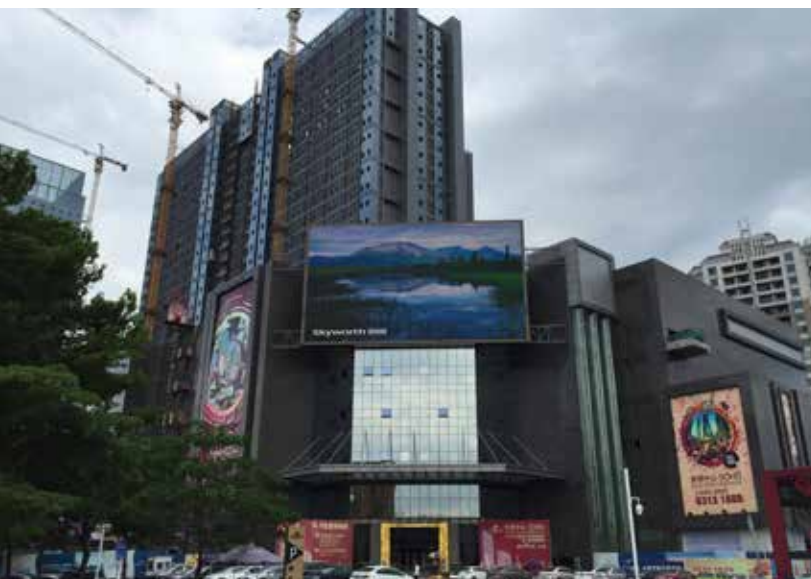
户外常规 LED 屏 佛山世博广场
